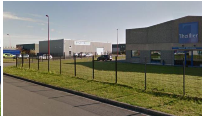
Bâtiments d'activité, rue du Chauffour (ZA la Broye)
