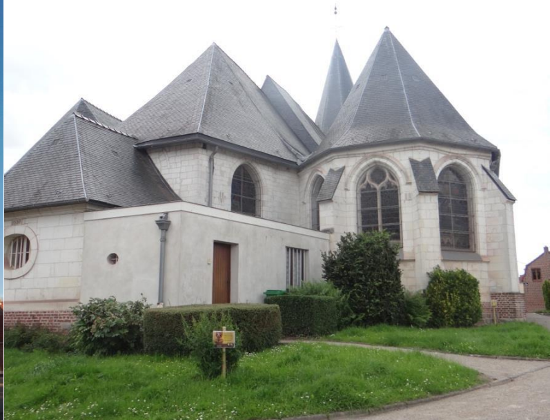
Nef latérale Nord - Fenêtre à remplage gothique flamboyant
