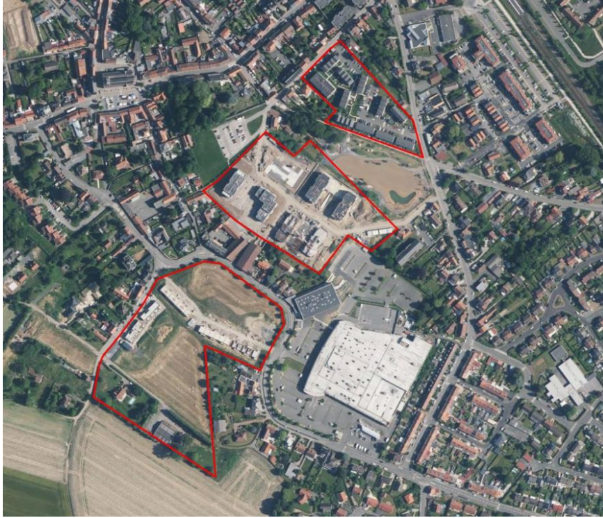
Périmètre du site de l'opération, identifiant les trois secteurs : nord, centre et sud (Géoportail)
