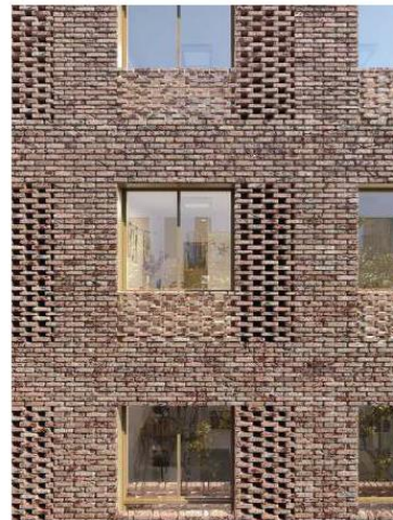
BRIQUE DE RÉEMPLOI POUR LES PAREMENTS & VÊTURES OU POUR LES PROTECTIONS SOLAIRES EXTÉRIEURES (CLAUSTRA)
