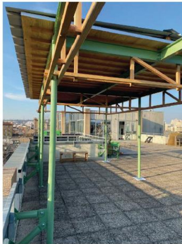
MÉTAL DE RÉEMPLOI POUR LES CHARPENTES & BARDAGES OU LES PROTECTIONS SOLAIRES
