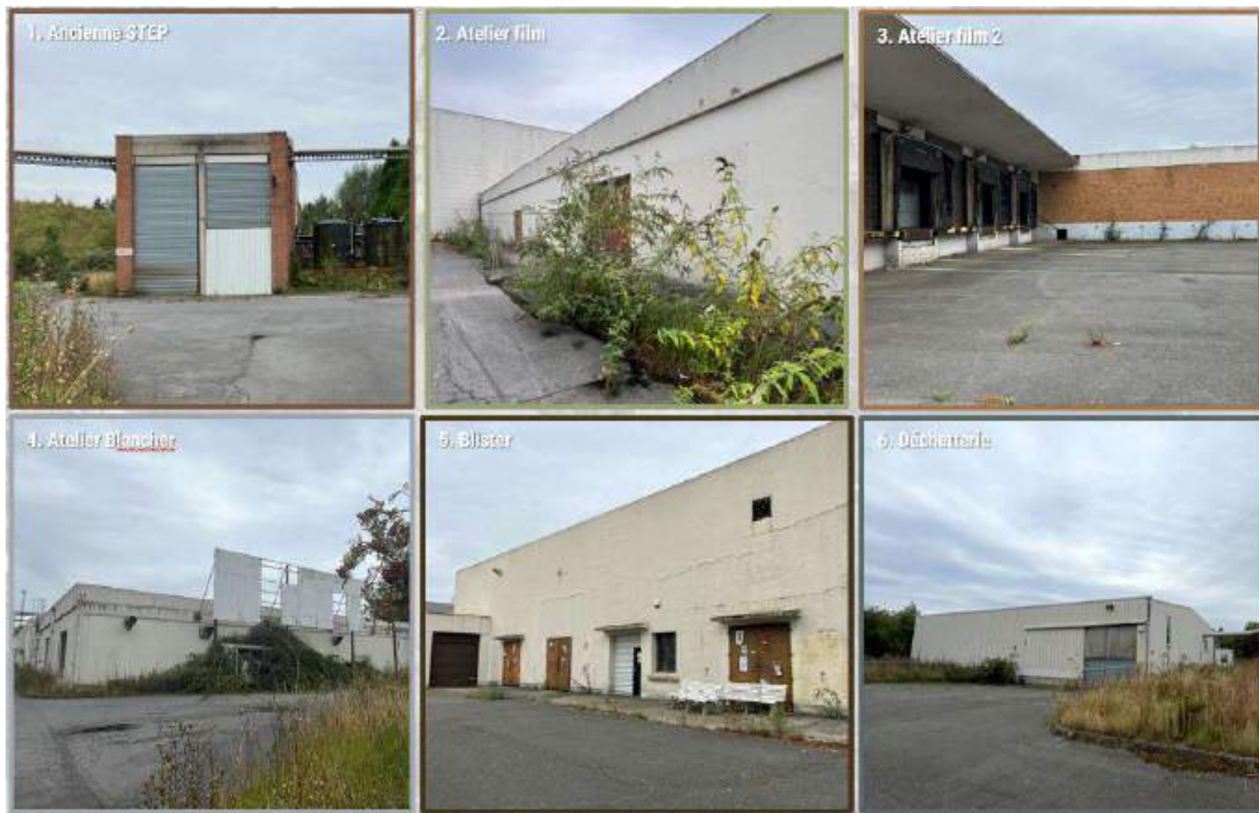
Figure 32.. Photos 1 à 6 des bâtiments prévus pour démolition, Verdi Conseil Nord de France – septembre 2024
