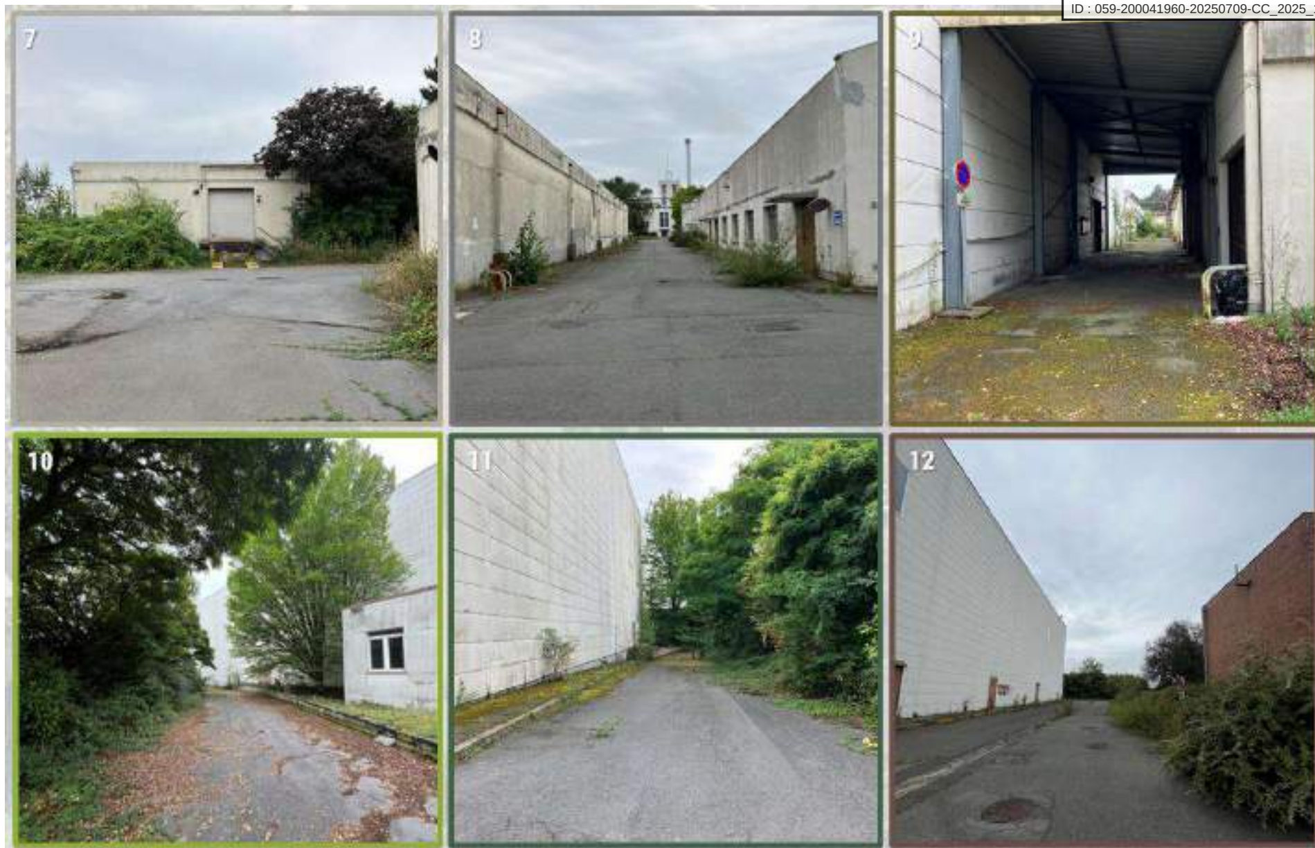
Figure 18. Photos 7 à 12 à l'intérieur du site, Verdi Conseil Nord de France – septembre 2024
