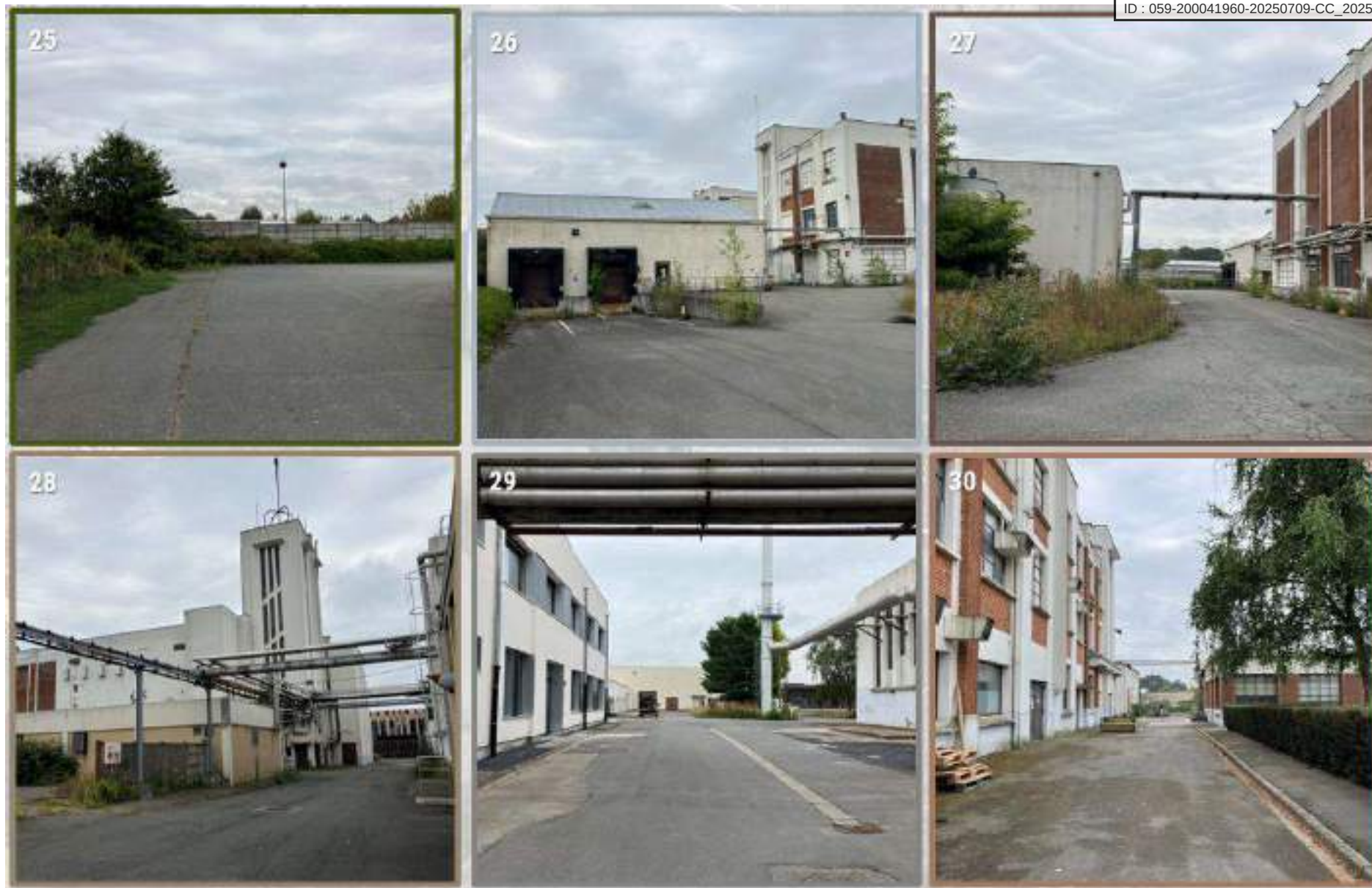
Figure 24. Photos 25 à 30 , à l'intérieur du site, Verdi Conseil Nord de France – septembre 2024
