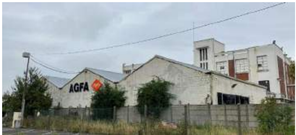
Figure 25. Vue sur l'enseigne Agfa sur le site de projet
