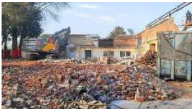
Déconstruction du site – mars 2025 (Pévèle C).
