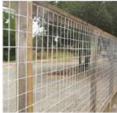
Clôtures en treillis soudé, mailles carrées et perforées bois autour de la boucle logistique (Sud du site)
