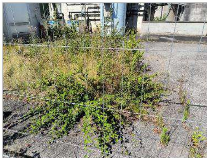
Figure 83. Au fond, la base des bassins de décantation de l'ancienne station d'épuration © Rainette, 2023
