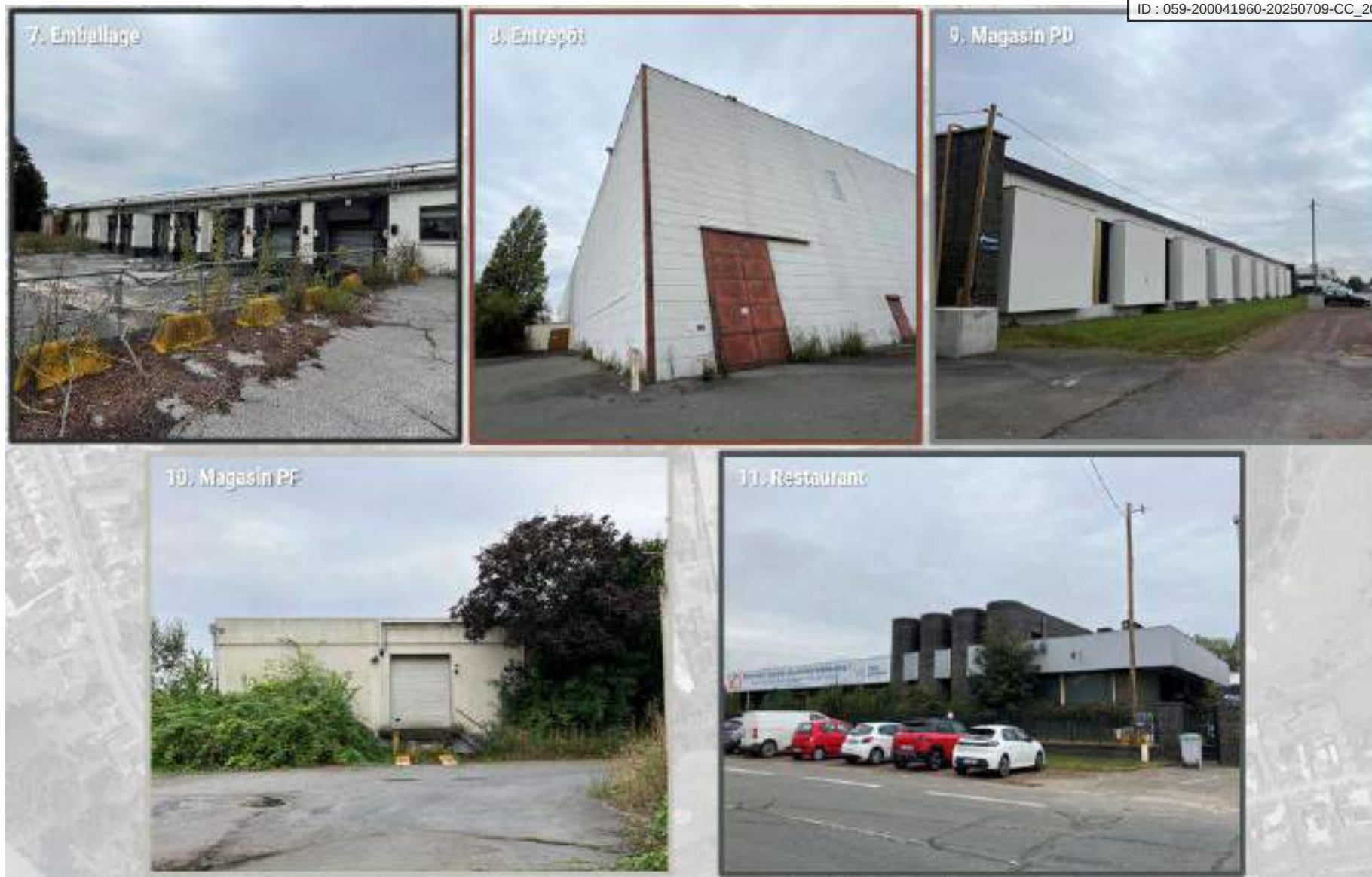
Figure 30. Photos 7 à 11 des bâtiments conservés, Verdi Conseil Nord de France – septembre 2024
