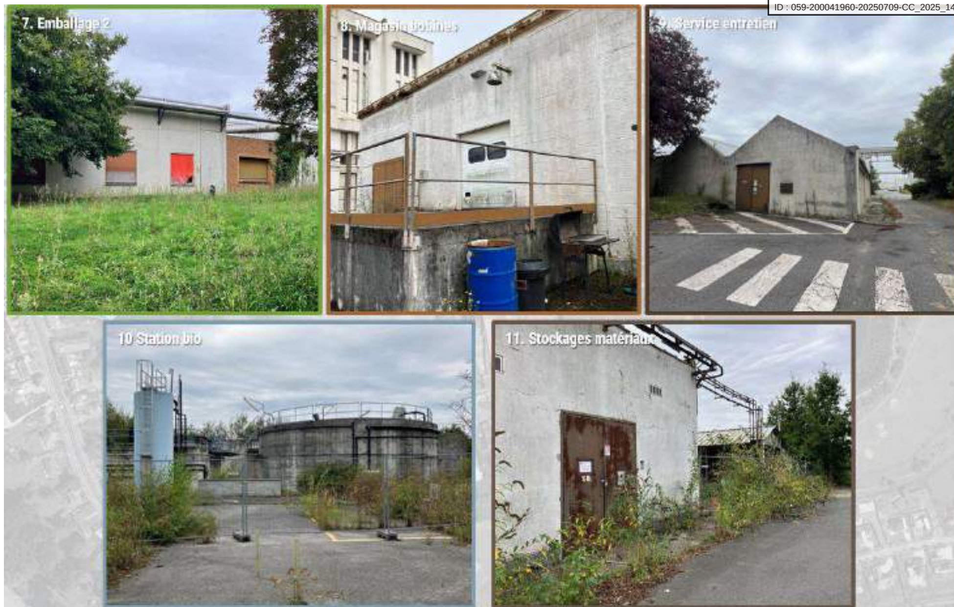
Figure 33. Photos 7 à 11 des bâtiments prévus pour démolition, Verdi Conseil Nord de France – septembre 2024
