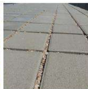
Pavés à joints graviers
