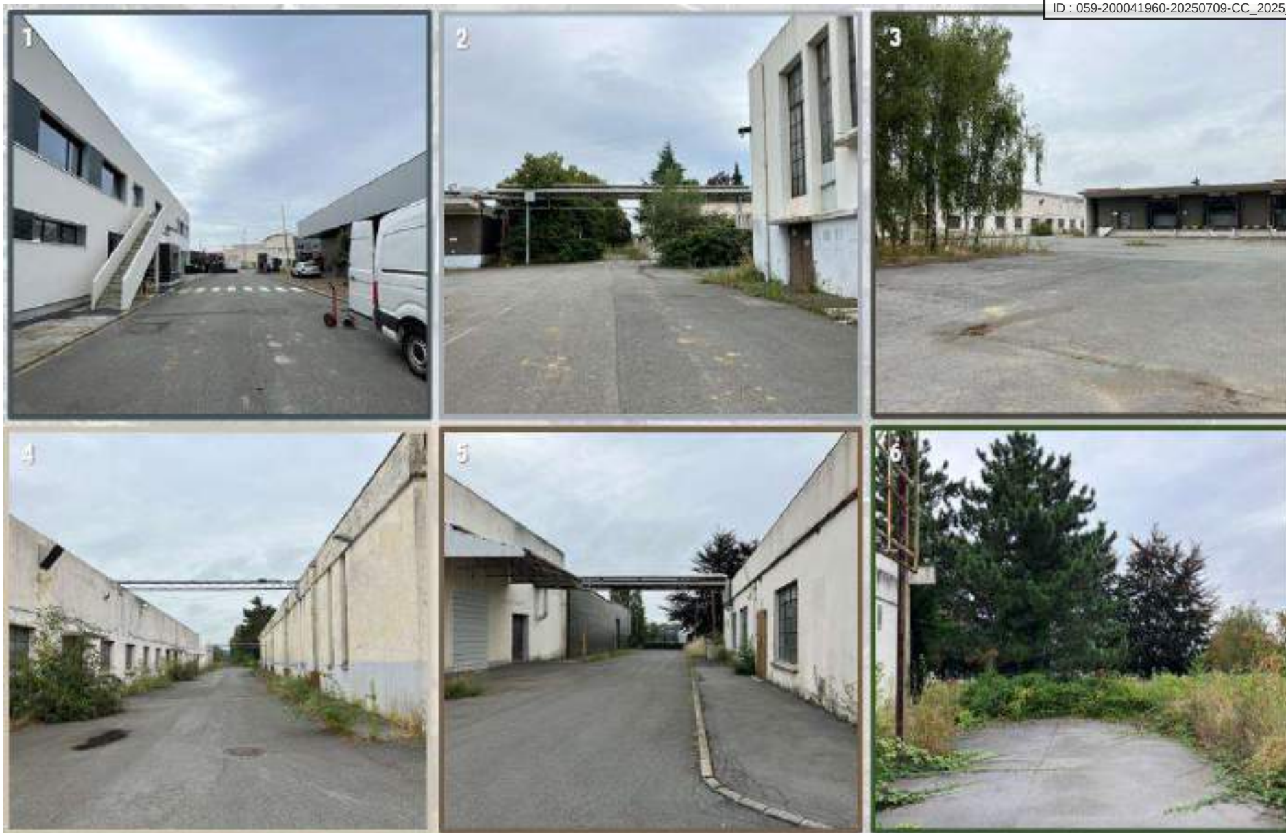
Figure 16. Photos 1 à 6, à l'intérieur du site, Verdi Conseil Nord de France – septembre 2024
