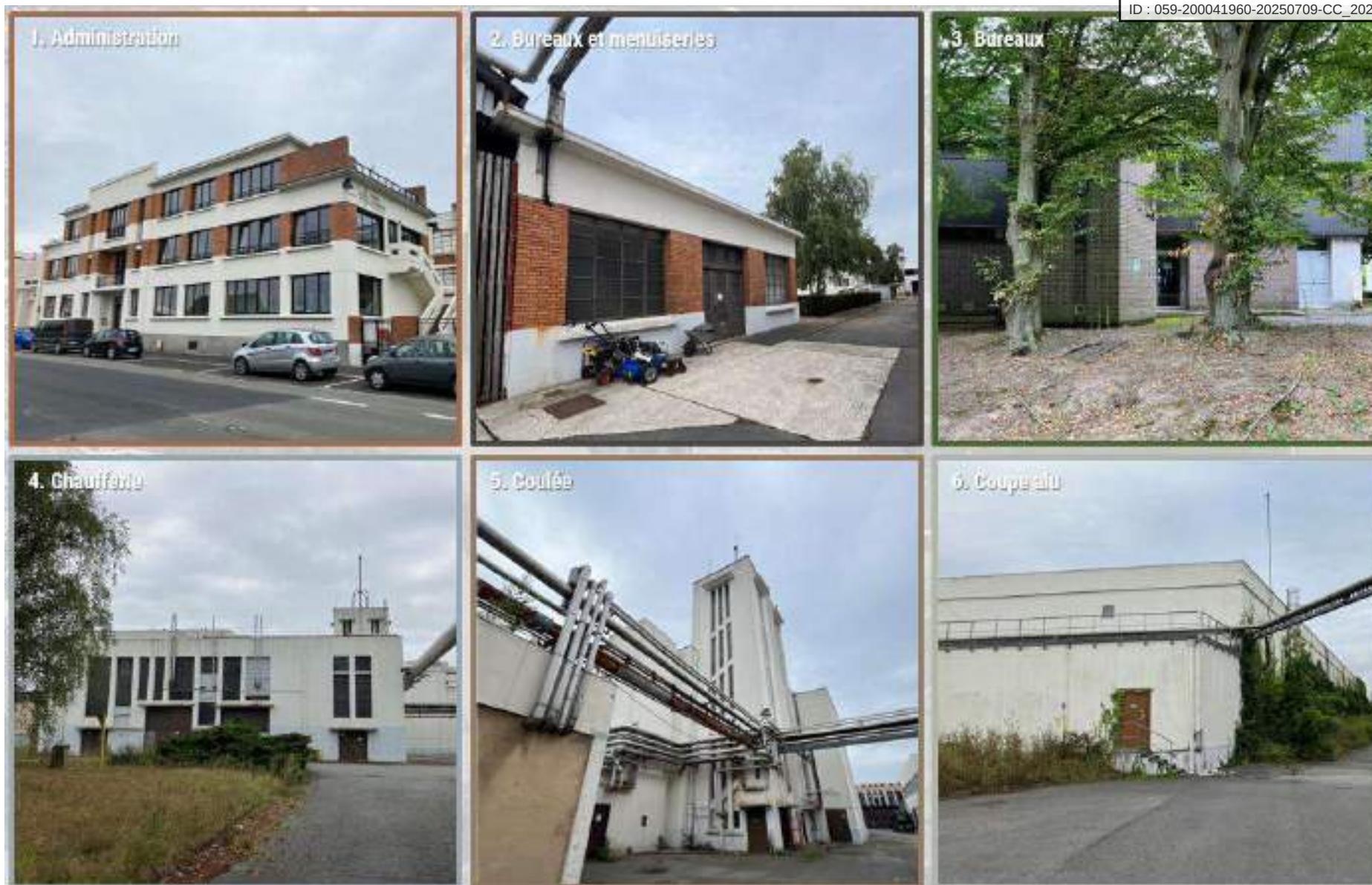
Figure 29. Photos 1 à 6 des bâtiments conservés, Verdi Conseil Nord de France – septembre 2024
