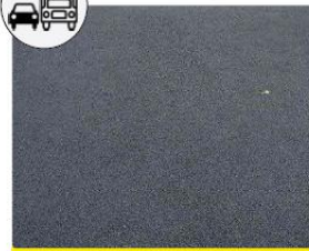
Voie circulée logistique : enrobé
