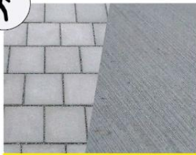
Voie mobilité douce : pavé infiltrant & béton balayé
