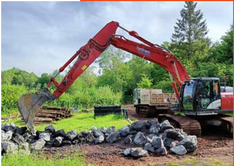
Travaux sur les berges de l'étang d'Ostricourt
