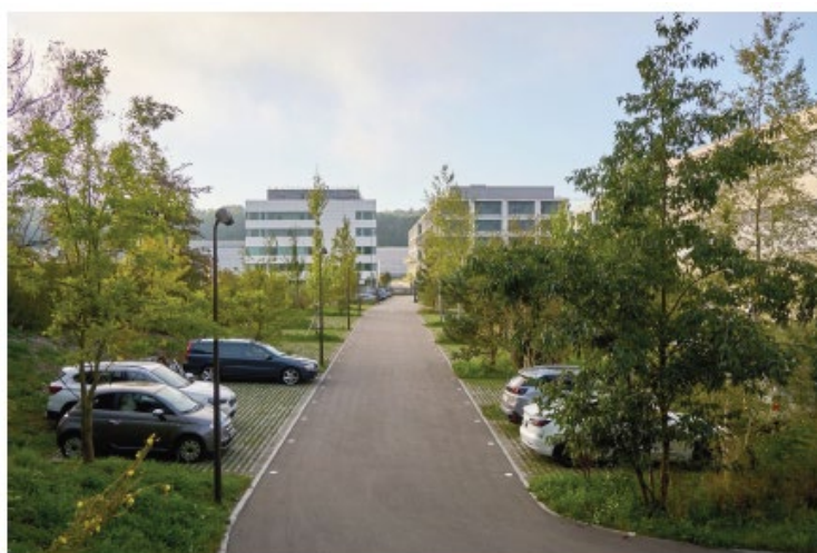
Une intégration paysagère qui donne une vraie qualité à ses espaces techniques
