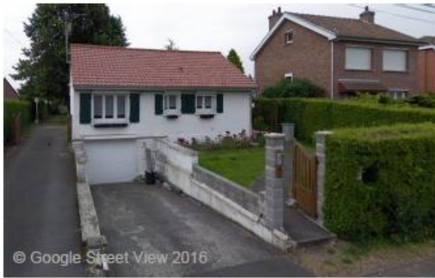
Pavillons individuels, rue de la Planque
