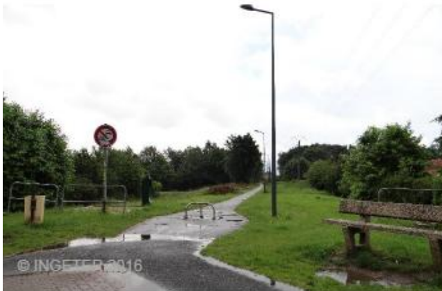
Voie verte, rue de la Planque
