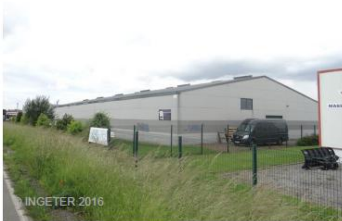
Bâtiments industriels, Avenue du Général de Gaulle
