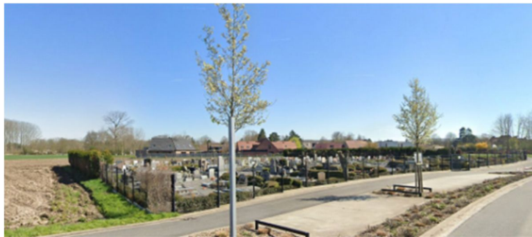
Vue du site du projet, venant du RD 94 en provenance de Bouvines
