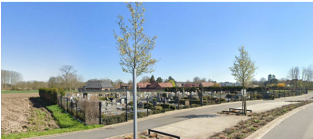
Vue du site du projet, venant de la RD 94 en provenance de Bouvines
